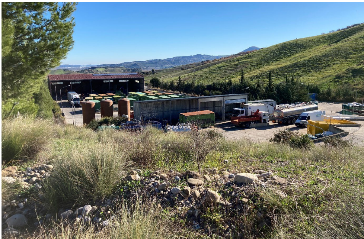
Figura 7 L'area dell'impianto esistente vista da N.
